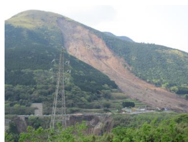
阿蘇大橋崩落現場
